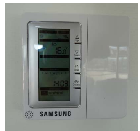
Iedere woning is voorzien van een MWR-WH00 wandbediening voor klimaatregeling (temperatuur, uitblaasrichting, timer, enzovoort).
